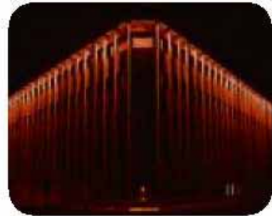
Illumination fixe du bâtiment de Romande Energie à Morges.
